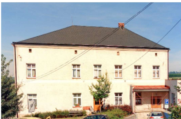
Foto: Střecha obecních bytů – krytina Capacco
